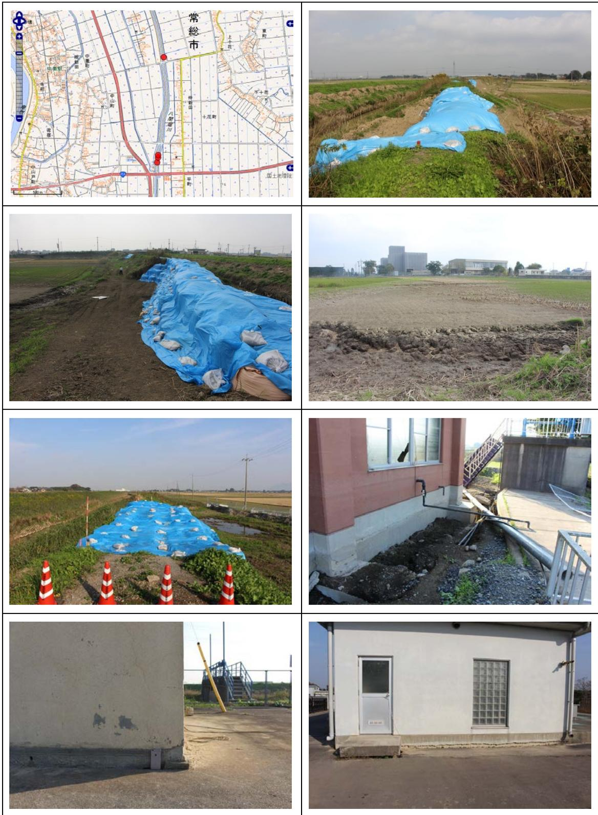
図-2.1.7 人間掘川の破堤地点の状況と建物周りの沈下（常総市平町と常総市川崎町）
