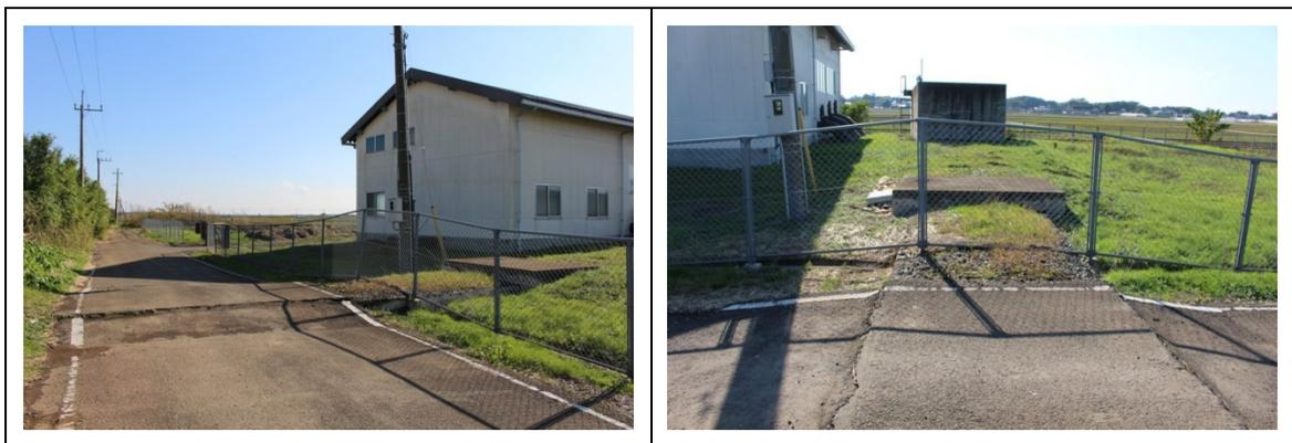
写真-2.1.2 飯沼川の越水地点付近の建物周りの沈下（地盤沈下）（常総市古間木新田）
